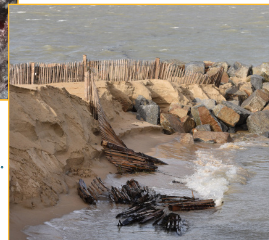
Dégats sur ganivelles observés à ..... la Pointe de Montmartin
