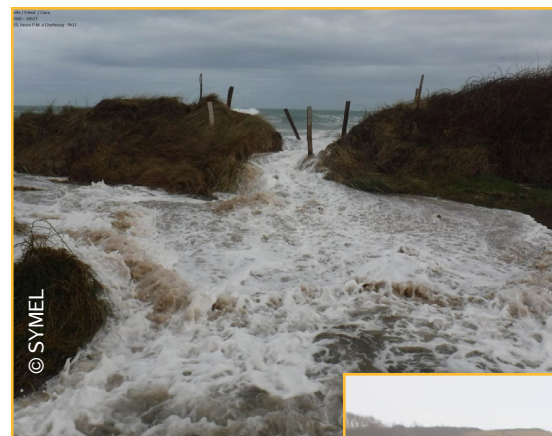
••• Brèche dans la dune bordière entraînant une submersion à Fermanville (50)
